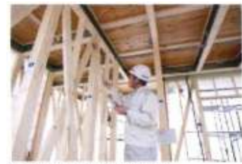
施工管理者等による施工検査
